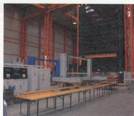
Mehr Platz: die neu gebaute Montagehalle
